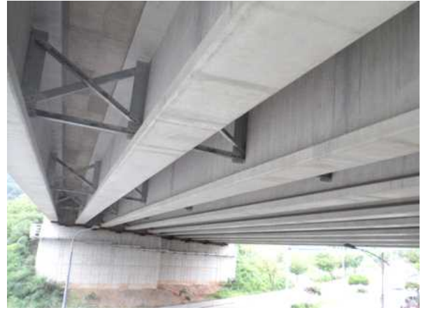
가로보 상태양호(SEG Beam 거더)
