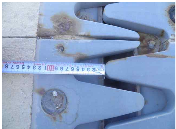
신축이음 이동량 측정
