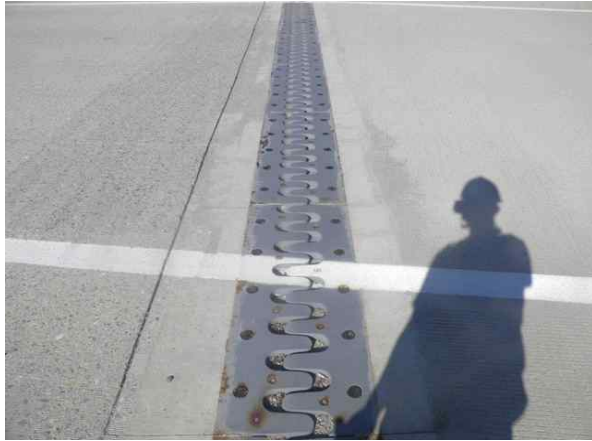
신축이음 A1 상태양호
