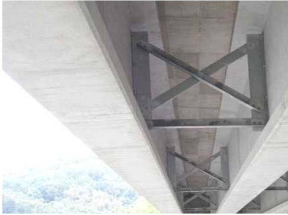
가로보 상태양호(SEG Beam 거더)
