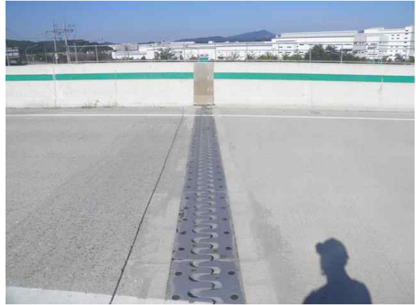
신축이음 A1 상태양호
