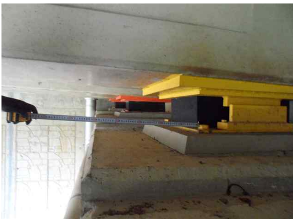
받침장치 연단거리 측정
